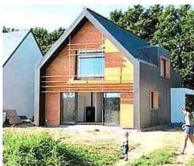
Maison bois zero energie à Guérande.
